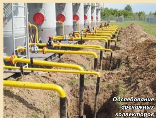
Обследование подключающих шлейфов со снятием изоляционного покрытия
