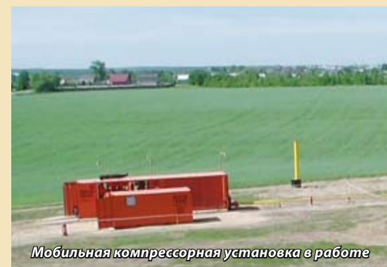
Трасса газопровода «Горький–Центр» 283 км
