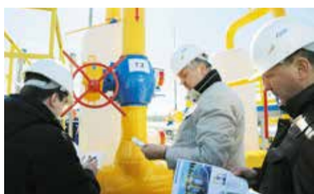
Капитальный ремонт ГРС
