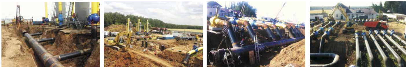
Работы по реконструкции КРП-16 (июнь–октябрь 2014 г.)
