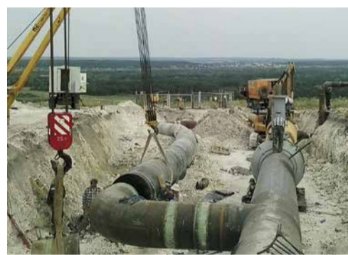
Внедрение рационализаторского предложения «Экономия затрат на приобретение трубы ДУ1020 при монтаже временной камеры запуска поршня для проведения ВТД на МГ САЦ 4-2»
