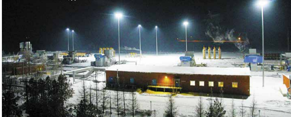
Новые прожекторные мачты со светодиодными энергосберегающими светильниками на КС-4 «Чаплыгин», Донское ЛПУМГ
