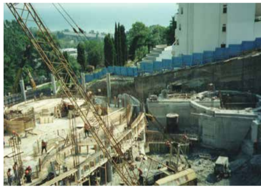
Строительство лечебного корпуса, блок А, 2003 год
