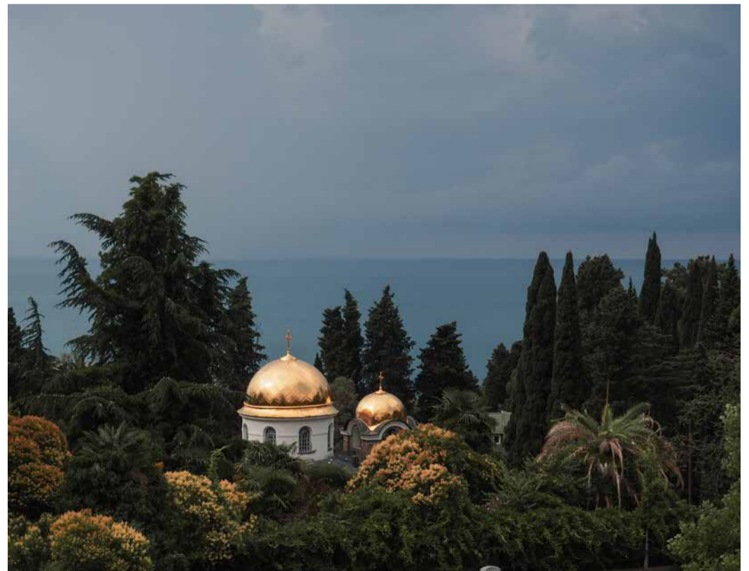
Храм Преображения возле третьего корпуса (в реконструкции участвовал ООО «Мострансгаз»)
