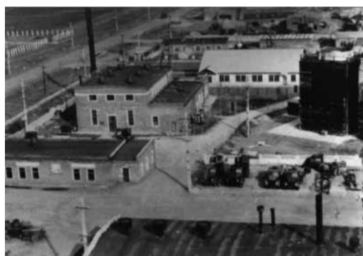
Строительство Острогожского районного УМГ
