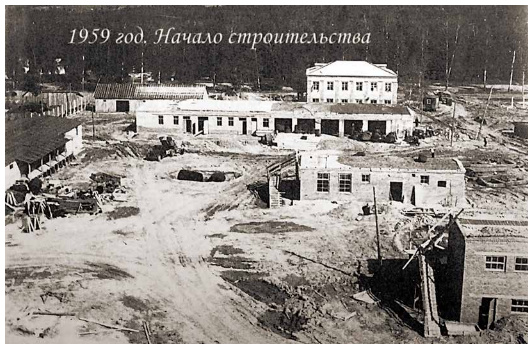
Начало строительства КС «Белоусово»
