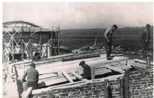
Строительство вспомогательного цеха и здания электростанции 4-го участка газопровода Саратов-Москва
