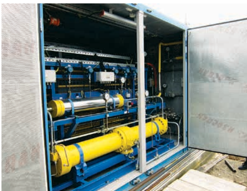
Рис. 3. Блок КПП на КС «Ефремовская»
