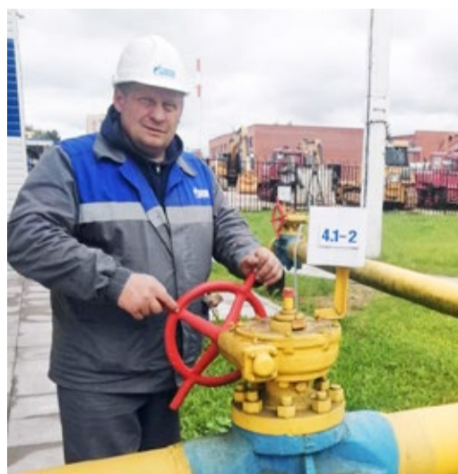
Трубопроводчик линейный обслуживает линейную часть МГ, контролирует состояние защитного покрытия трубопроводов и сооружений, выполняет вспомогательные работы при вскрытии траншей трубопроводов, сварке, продувке и испытании, при ремонте запорной арматуры, водосборников и других устройств и сооружений на трубопроводе
