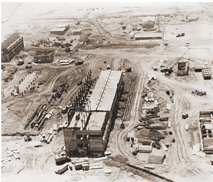
Строительство третьего цеха КС «Долгое»
