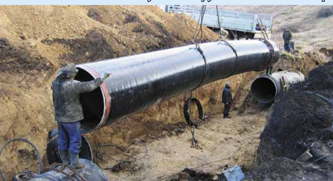
Замена участка трубы большого диаметра
