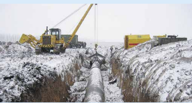
Замена участка трубы большого диаметра
