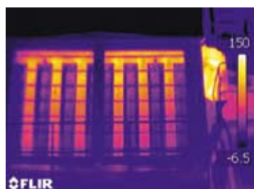
Работа СПЦВ после перемонтажа
