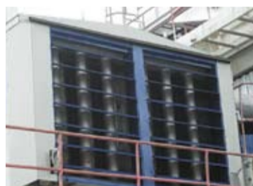
Конструкция коробов СПЦВ после перемонтажа
