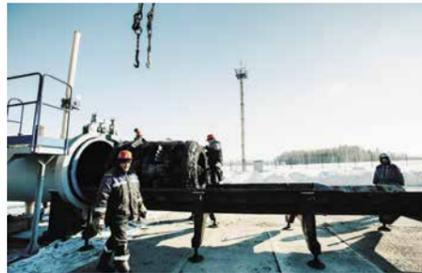
ляющих опасность для эксплуатации газопроводов, заменено 3755 м трубы. Работы по устранению дефектов продолжаются.
