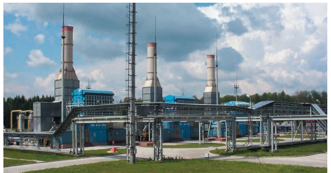
Общий вид станции Белоусовского ЛПУМГ с северной стороны
