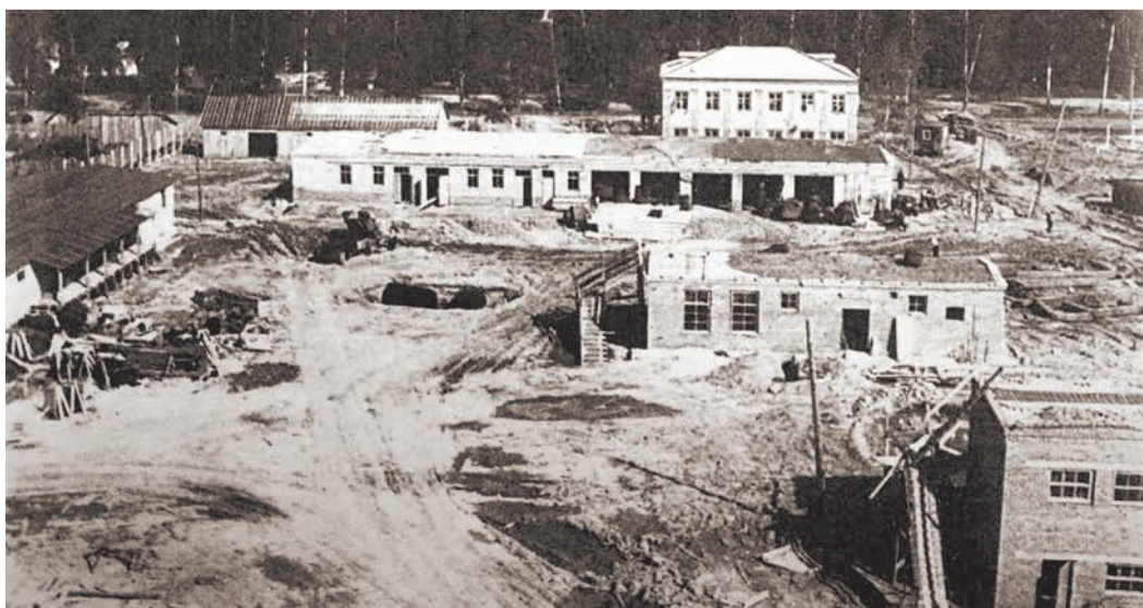
1959 год. Начало строительства станции в п. Белоусово
