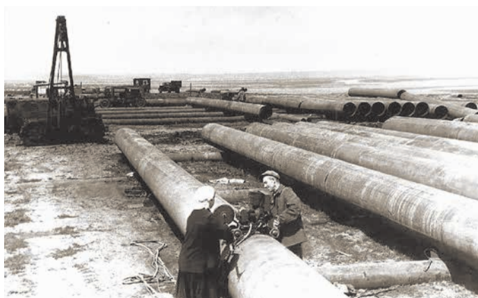
Строительство газопровода Ставрополь–Москва
