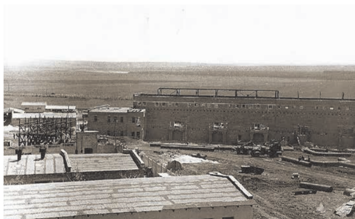
Строительство газоперекачивающего цеха КС-6 с турбинами ГТ-700-4
