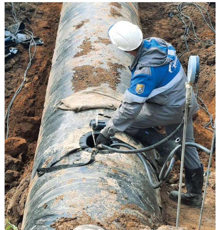
Способ безопасной установки и извлечения временного герметизирующего устройства из газопровода. Брянское ЛПМУГ
