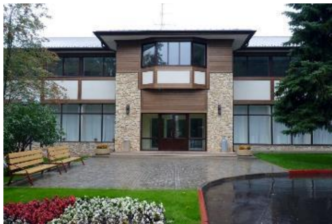
Рисунок № 1. Здание Учебно-производственного центра
